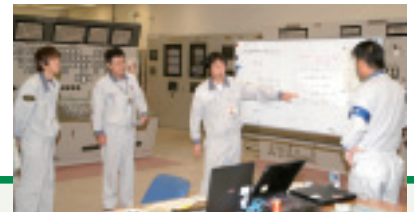
中央制御室における試験前確認
