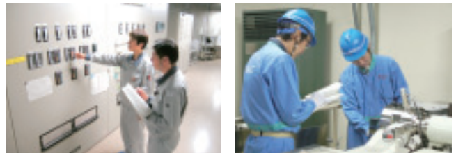
プラント確認試験の様子
